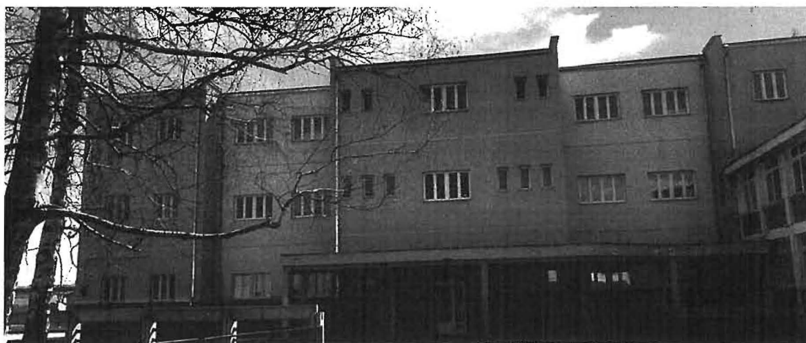
Фотографије фасада објекта бр. 1 – стара школа
