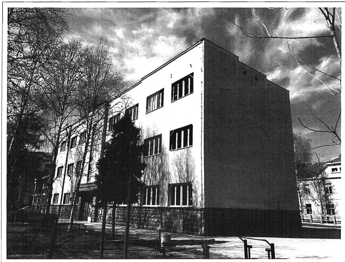
Фотографије фасада објекта бр. 1 – стара школа
